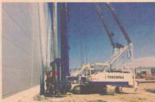
Toscapali. Battipalo al lavoro
